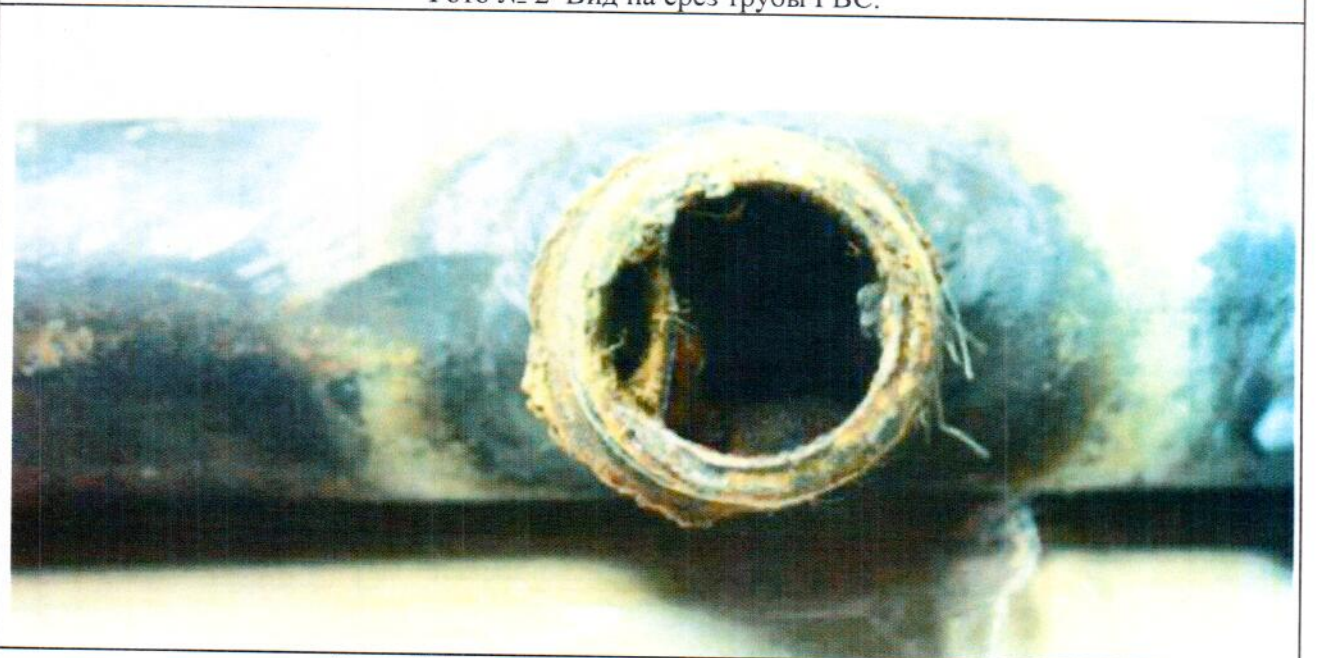
Фото № 3. Вид на отвод на полотенцесушитель.
