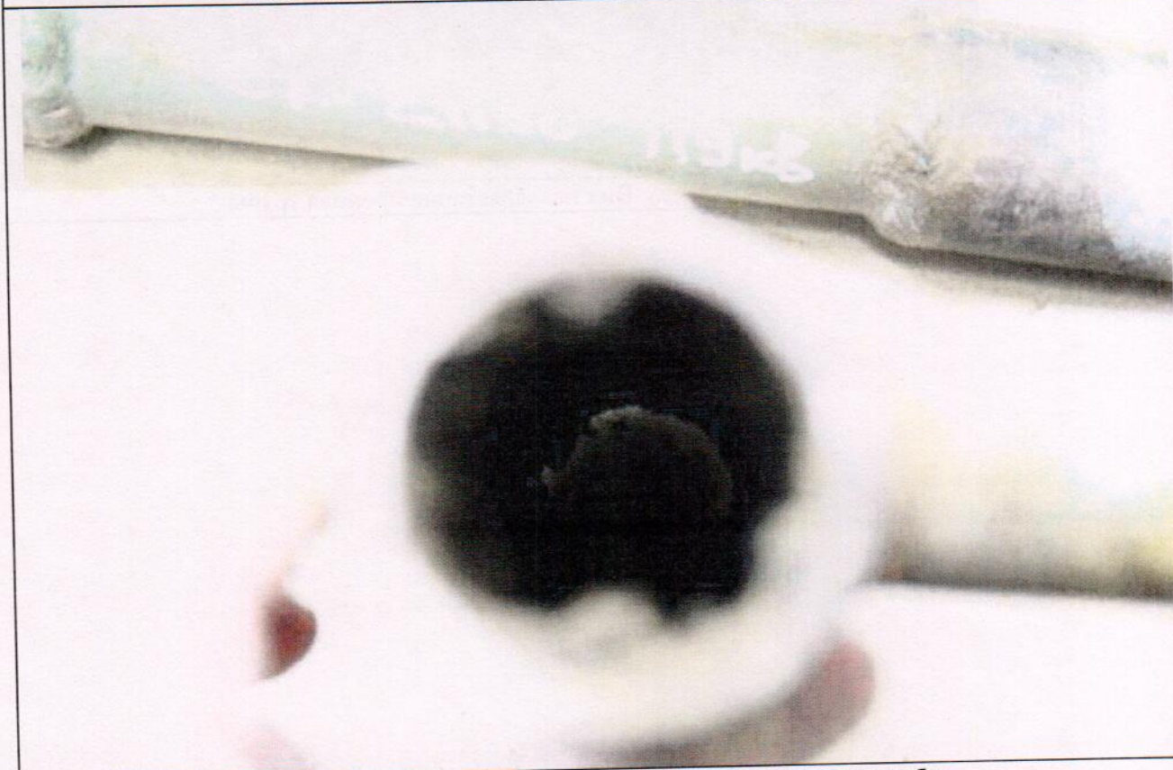
Фото № 17. Вид на срез трубы. Заращение прохода трубы.
