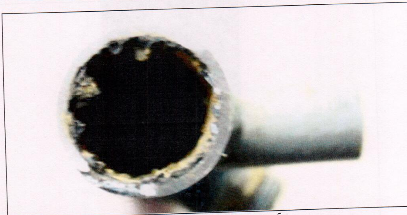
Фото № 70. Заращение прохода трубы.
