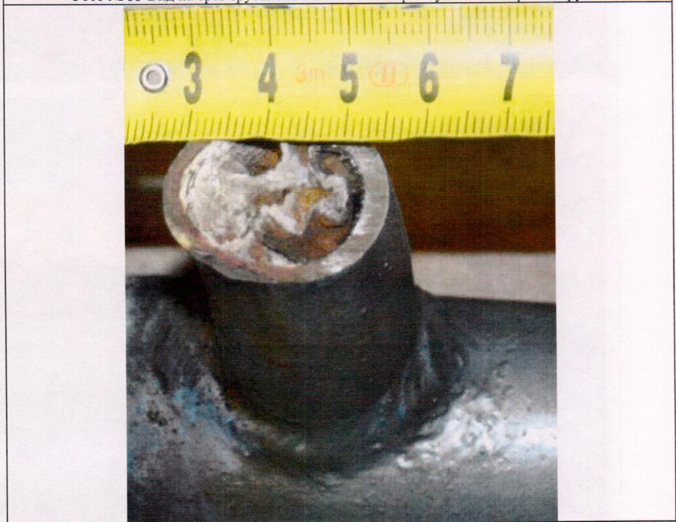
Фото № 34 Вид на срез трубы. Почти на 90 % закрыт условный проход трубы.
