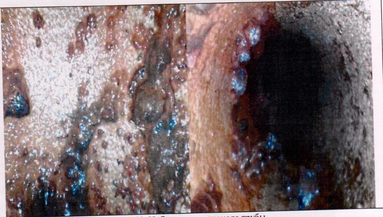
Фото № 58. Заращение прохода трубы.
