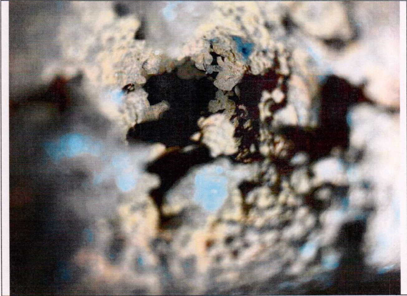
Фото № 54. Заращение прохода трубы.
