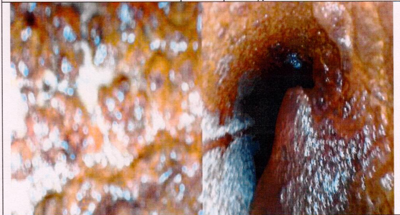
Фото № 55. Заращение прохода трубы.
