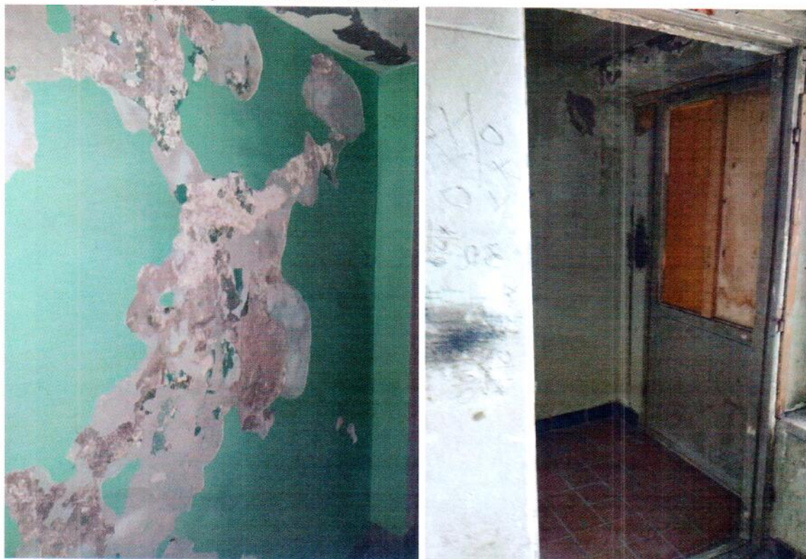
Фото 14 – 15. Тамбура выхода на переходной балкон.
